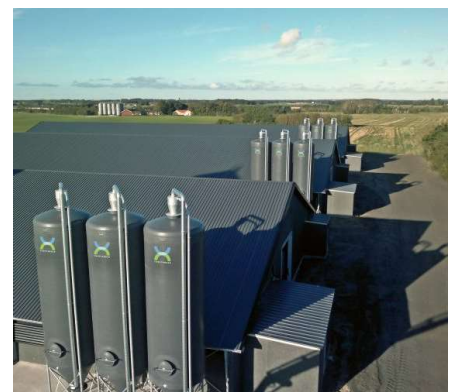
Figur 4-3. Glasfibersiloer egner sig godt til opbevaring af færdigfoder og koncentrat til foderblandinger. De fås i mange forskellige farver.
